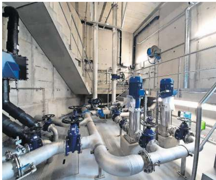
Das neue Reservoir von innen.
