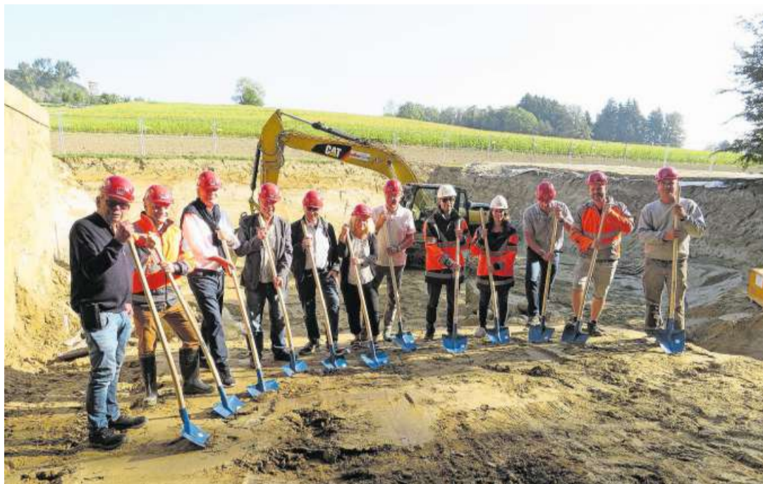
Vertreter von Behörden, Bauunternehmung und dem Regionalen Wasserverband Mutschellen beim Spatenstich zur Erweiterung des Reservoirs Gugelholz beim Hasenberg. Bild: Marc Ribolla
